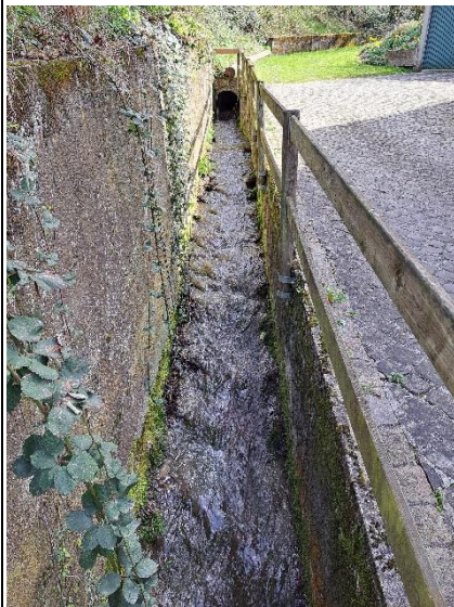
Abbildung 1: Foto Ortsbegehung Wibergtöbelibach
